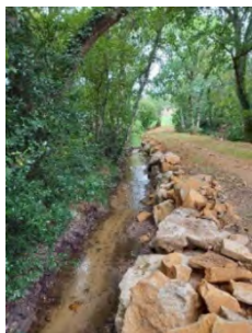
Aménagement de passage à gué à St-Evarzec, juillet 2022
