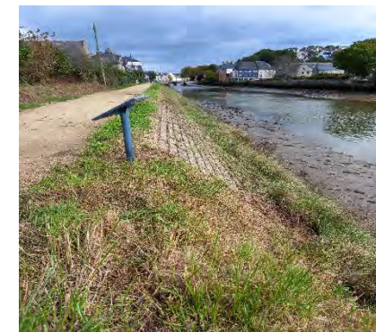
Système d'endiguement du Halage
