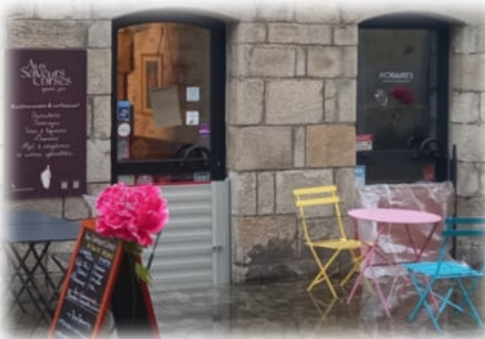
Batardeau mis en œuvre par un commerçant en centre-ville de Quimper
